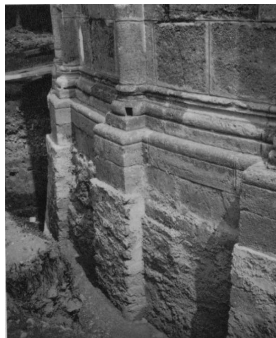
Abb. 28 bis 31: Rundkirche Petronell, Vormauerung mit Vorbereitung und Ausführung auf dem bereits hergestellten Fundament.
