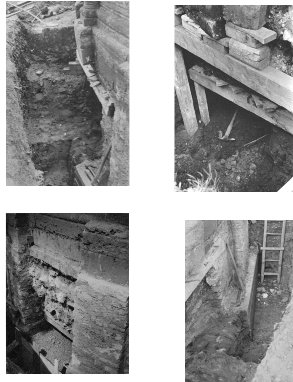
Abb. 24 bis 27: Rundkirche Petronell, Arbeiten im Zuge der Herstellung der Fundamentunterfangung von Ausschachtung, Untergrabung, Betoneinbringung bis zum fertigen Fundament.
