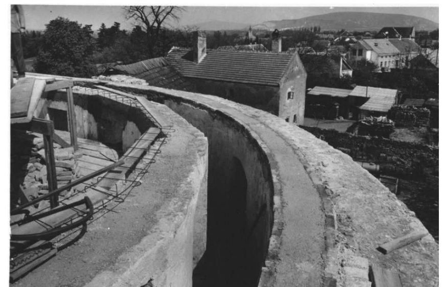
Abb. 38: Rundkirche Petronell, Stahlbetonrost zur horizontalen Verschließung des Gebäudes mit Einblick in den Rundgang (vgl. Schnitt in Abb. 14 und 15 , äußerer Rost noch nicht hergestellt)
