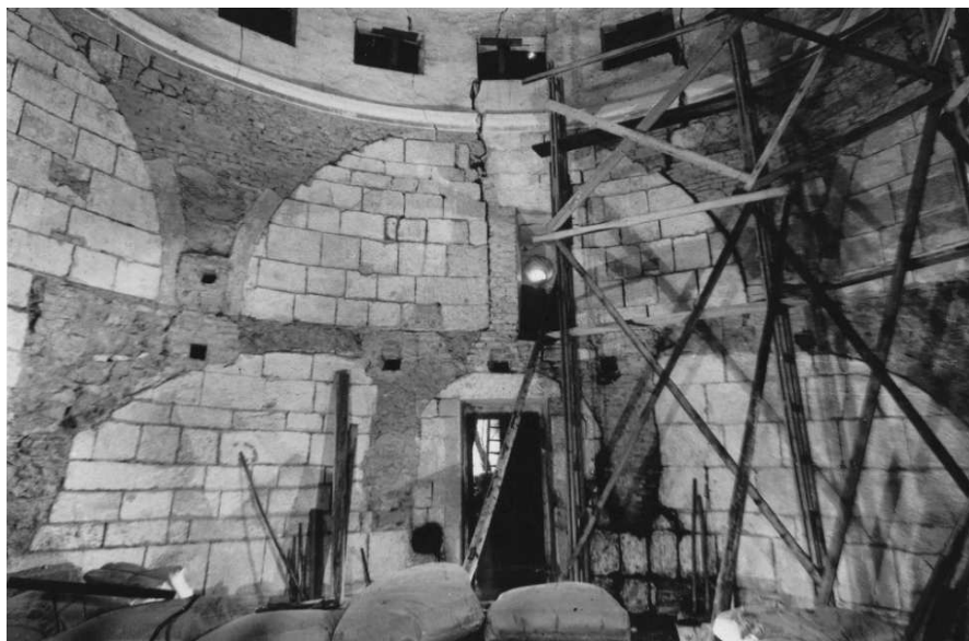
Abb. 36: Rundkirche Petronell, Innenansicht mit Quadermauerwerk und Ausmauerungen der entfernten Gewölbeeinbindungen.
