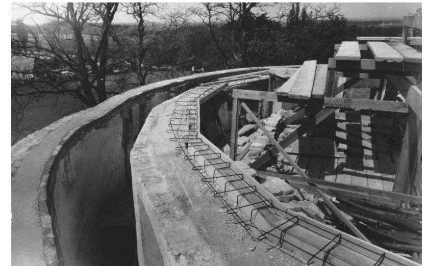
Abb. 37: Rundkirche Petronell, Stahlbetonrost zur horizontalen Verschließung des Gebäudes mit Einblick in den Umgang (vgl. Schnitt in Abb. 14 und 15 , äußerer Rost noch nicht in Arbeit)
