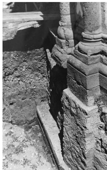
Abb. 28 bis 31: Rundkirche Petronell, Vormauerung mit Vorbereitung und Ausführung auf dem bereits hergestellten Fundament.
