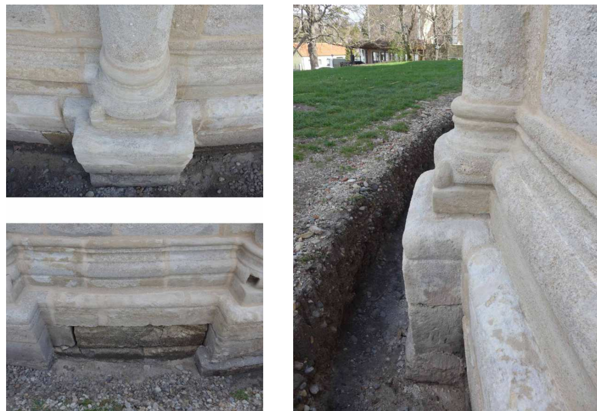
Abb. 52 (links) und 53: Rundkirche Petronell, Sockelzone, Freilegung und Sanierung
