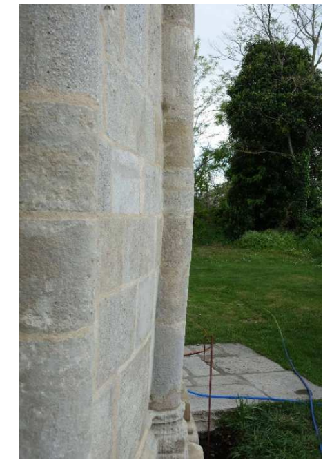
Abb. 42: Eingangsportal mit Sanierung der Mauerwerksrisse (vgl. Abb. 40 aus 1999)
