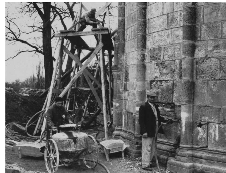
Abb. 34: Rundkirche Petronell, Sanierung der äußeren Mauerschale mit dem Torkretverfahren (Auspressen der Mauerrisse und Hohlräume mittels Mörtel)
