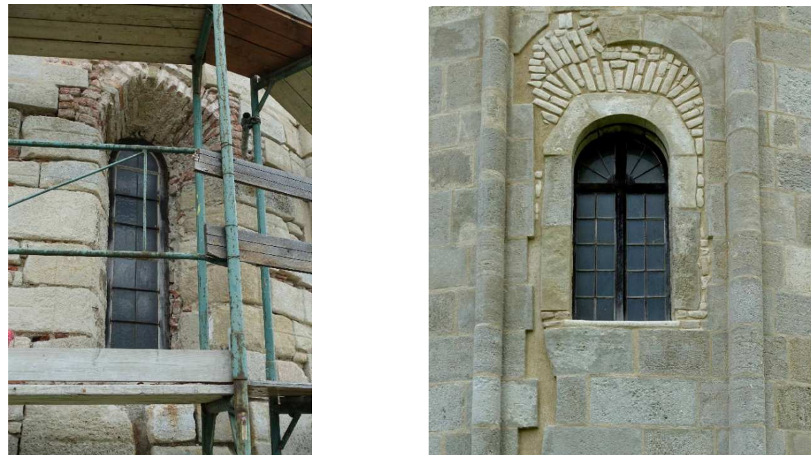
Abb. 50 und 51: Rundkirche Petronell, Apsisfenster im Zuge der Sanierung, Fenster Zentralbau Sanierung abgeschlossen
