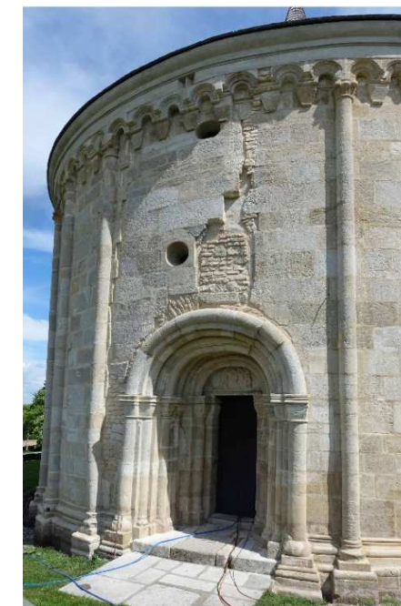
Abb. 42: Eingangsportal mit Sanierung der Mauerwerksrisse (vgl. Abb. 40 aus 1999)
