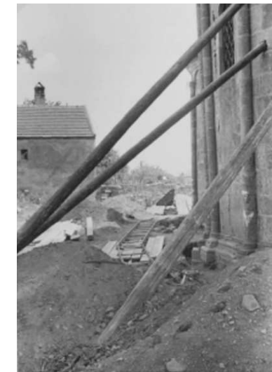
Abb. 32 und 33: Rundkirche Petronell, Vorbereitungsarbeit zur Sanierung der äußeren Mauerschale
