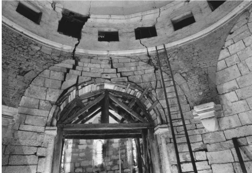
Abb. 35: Rundkirche Petronell, Apsisbogen mit Schalung zur Sicherung und Sanierung des beschädigten Gewölbes. Rechts eine Konsole (Kämpfer des abgebrochenen Gurtbogens).
