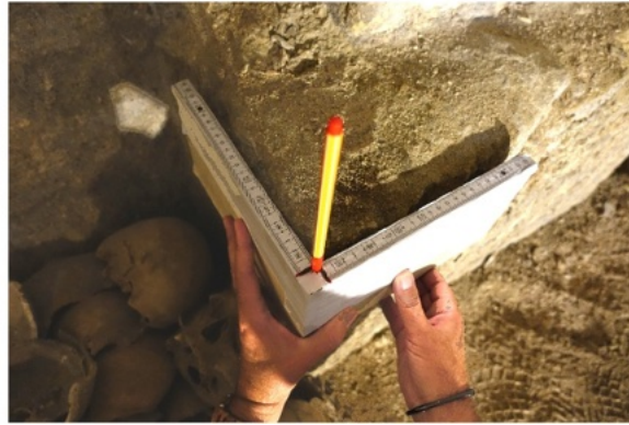
Abb.10: Detailaufnahme der Wandpfeilerecken mittels Eckschablone zur Rekonstruktion der Ecken, die im Bestand abgewittert sind.
