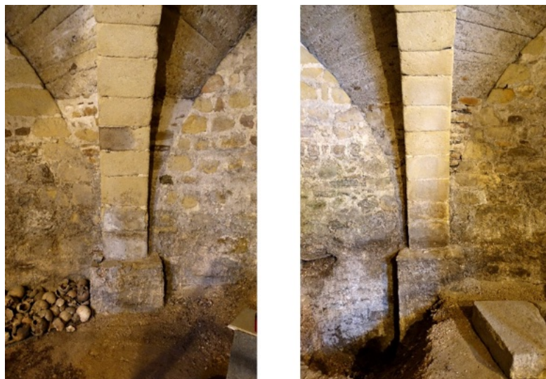
Abb.18: Tullner Karner, Untergeschoß, Wandpfeiler die das Kreuzrippengewölbe tragen (rechts Probegrabung)
