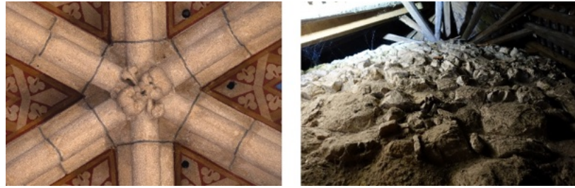
Abb.30: Tullner Karner Schluss-Stein und Gewölbe im Dachboden
