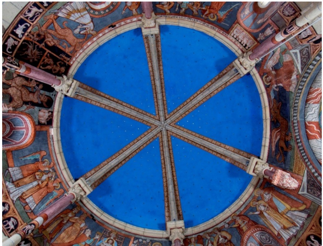
Abb.29: Tullner Karner, Zentralbau, sechsteiliges Rippengewölbe mit Wandgliederung das gegenüber der Karnerachse um 4.56^\circ nach Süden verdreht ist (Orientierung Palmsonntag 1245)
