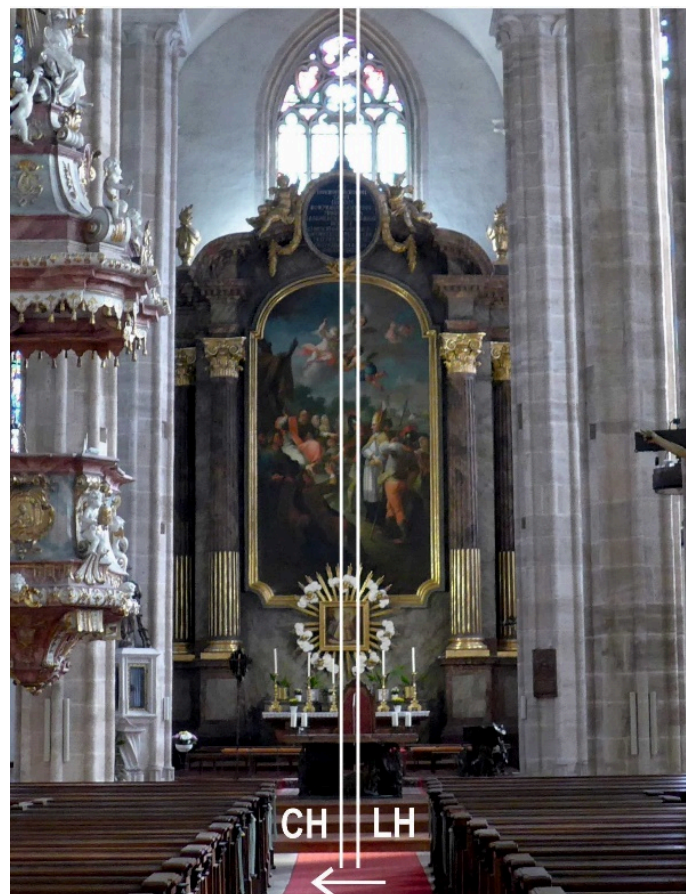
Abb.14: Mödling, Pfarrkirche St. Othmar mit Achsknick nach Norden (Knickwinkel ca.1.02°)
