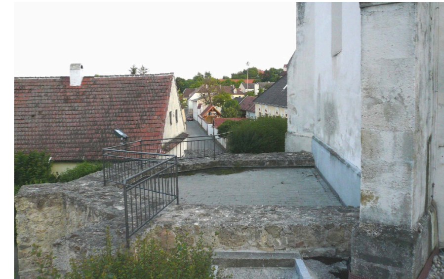
Abb.24: Pfarrkirche Nußdorf ob der Traisen (Niederösterreich, Bez. St. Pölten), Chorerweiterung, die nicht vollendet wurde. Der gerade Chorschluss sollte durch einen 5/8-Chor ersetzt werden. Hergestellt wurde das Fundament, der Durchbruch unterblieb.
