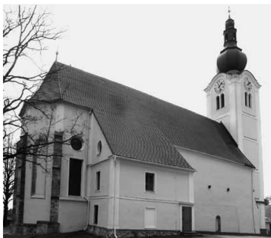
Abb. 15: Pfarrkirche Friedberg (hl. Jakobus der Ältere), Ansicht von Nordosten. Gründungsbau (romanische Chorquadratkirche, Grundriss Abb. 16), Erweiterung: gotischer 5/8-Chor, Kapellen und barocker Turm.
