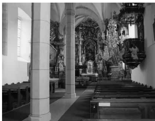
Abb. 17: Pfarrkirche Friedberg, Blick nach Osten mit gotischen Mittelschiffpfeilern und 5/8-Chor (Einwölbung des Langhauses der romanischen Chorquadratkirche).
