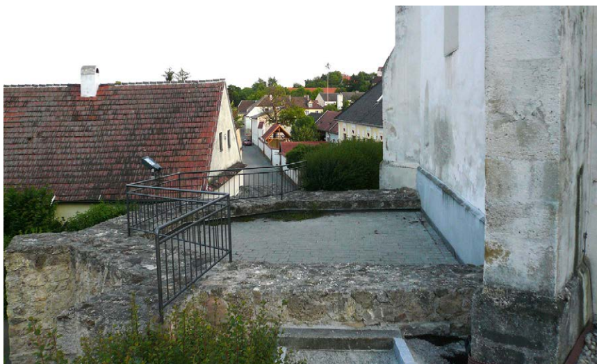
Abb. 24: Pfarrkirche Nußdorf ob der Traisen (Niederösterreich, Bez. St. Pölten), Chorerweiterung, die nicht vollendet wurde. Der gerade Chorschluss sollte durch einen 5/8-Chor ersetzt werden. Hergestellt wurde das Fundament, der Durchbruch unterblieb
